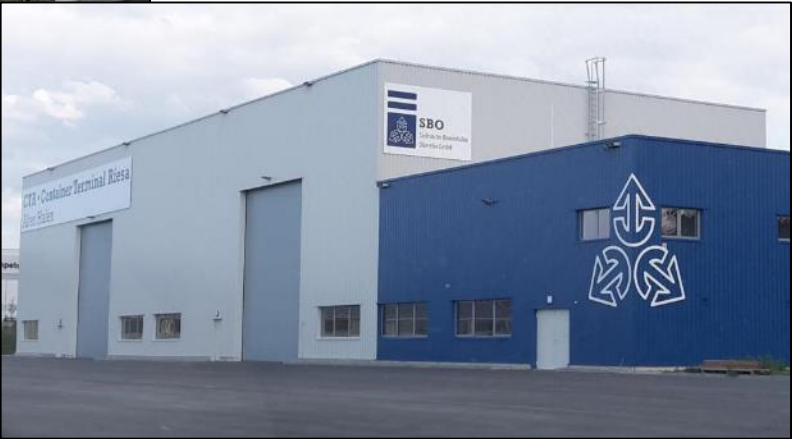
Hafen Riesa, Containerservicehalle
