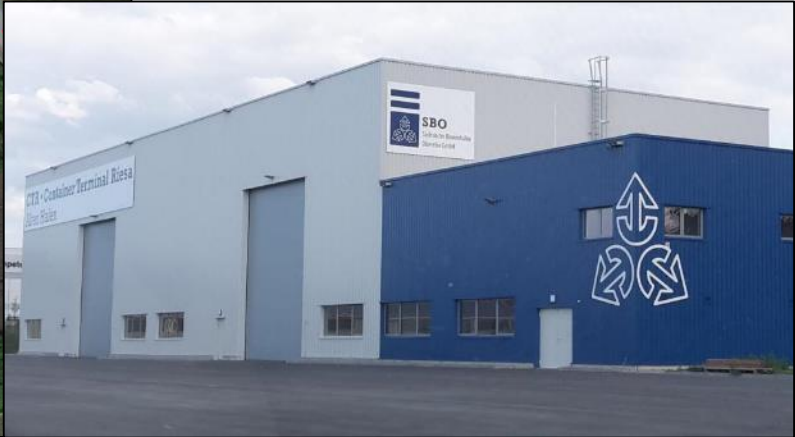
Hafen Riesa, Containerservicehalle
