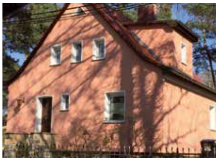
Dr.-Ing. Raik Hamann trocknet das Gemäuer seines Hauses kreativ, ohne Bauaufwand und erfolgreich mit dem patentierten Matrolan. Service und Einbau realisierte die Firma Groß aus Struppen bei Pirna.
